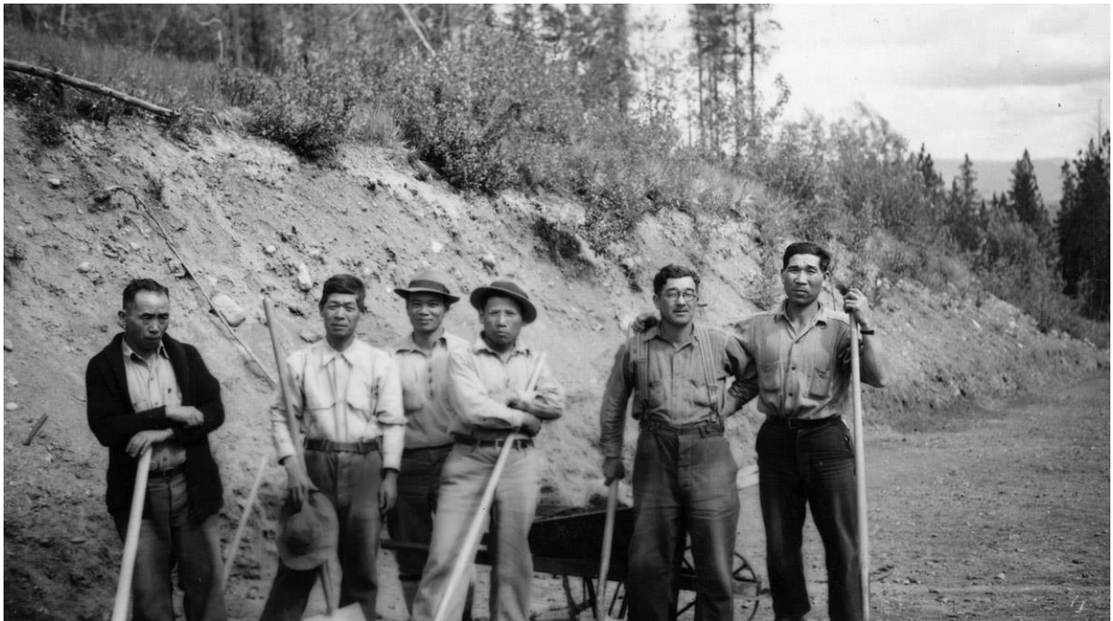
(写真5 ホープ・プリンス頓道路建設現場)
