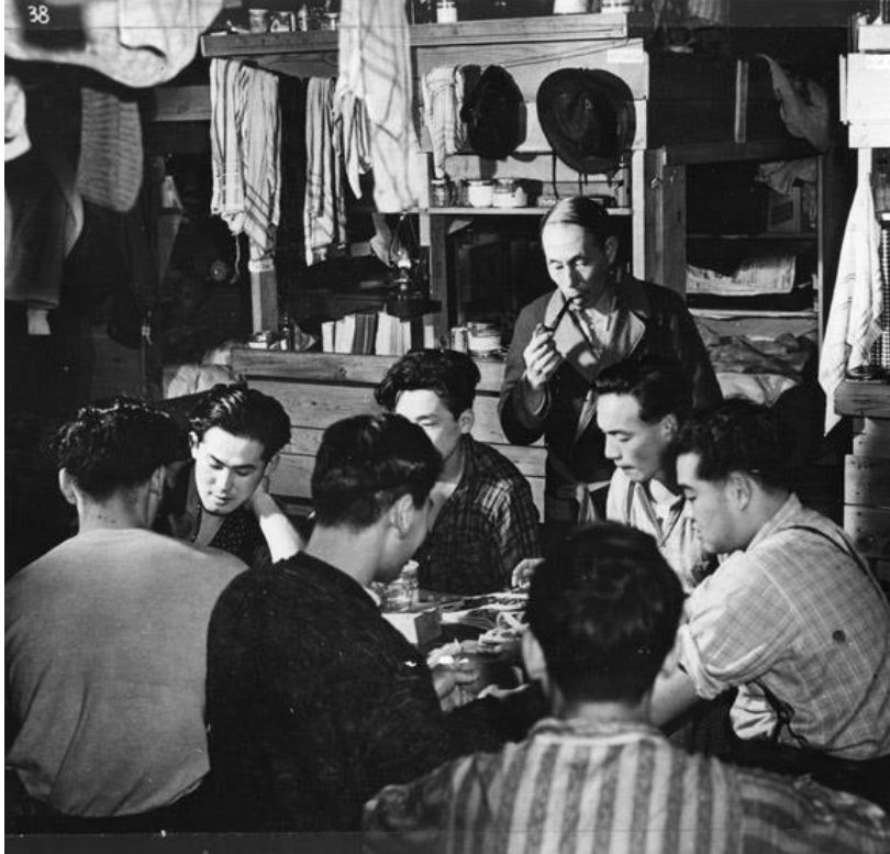
(写真4 マイル15道路建設飯場でくつろぐ人々)
