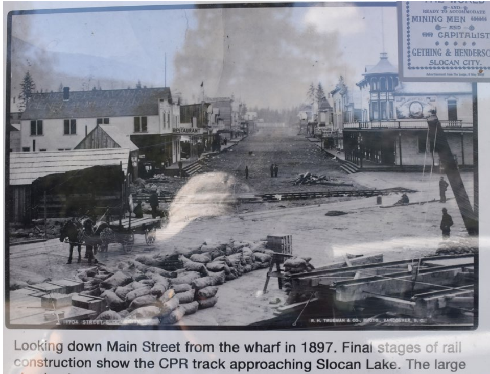
1897年のスローカン、蒸気船の発着所からハロルド・ストリートを眺める。手前に鉄道線路が建設中であるのがわかる。ここがCRPのターミル駅になる。
